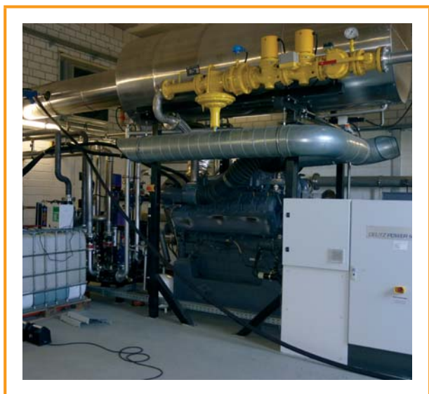
Figura 6.8: Usina de cogeração com linha de gás [DBFZ]
