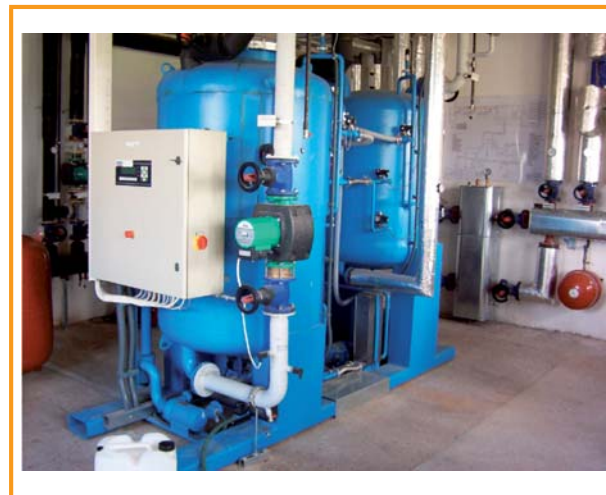
Figura 6.14: Exemplo de refrigerador de absorção em uma usina de biogás [DBFZ]
