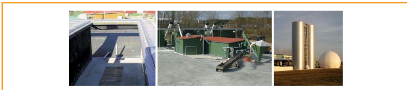
Figura 3.28: Exemplos de configurações especiais na fermentação a seco; reator sequencial em batelada (esquerda), biodigestor de baia com agitador (centro), estágio de metanização da digestão seca/úmida e gásômetro externo (direita) [Leibniz-Institut für Agrartechnik Potsdam-Bornim e. V. Potsdam (esquerda), Mineralit GmbH (centro), GICON GmbH (direita)]
