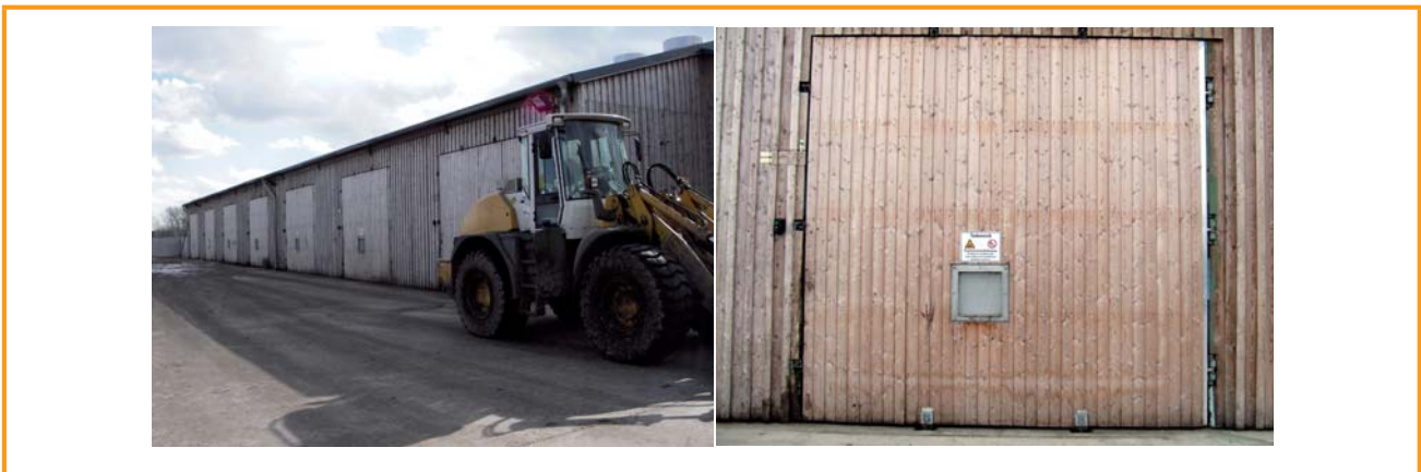
Figura 3.26: Exemplo de biodigestor de baia; bateria de biodigestores [Weiland, vTI] e portão do biodigestor [Paterson, FNR]
