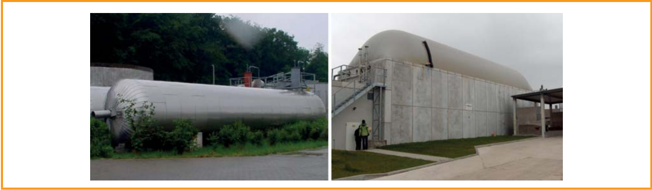
Figura 3.25: Biodigestor de fluxo pistonado; exemplos práticos, cilíndrico (esquerda), retangular, com gasômetro montado no topo (direita) [Novatech GmbH (esquerda), DBFZ (direita)]
