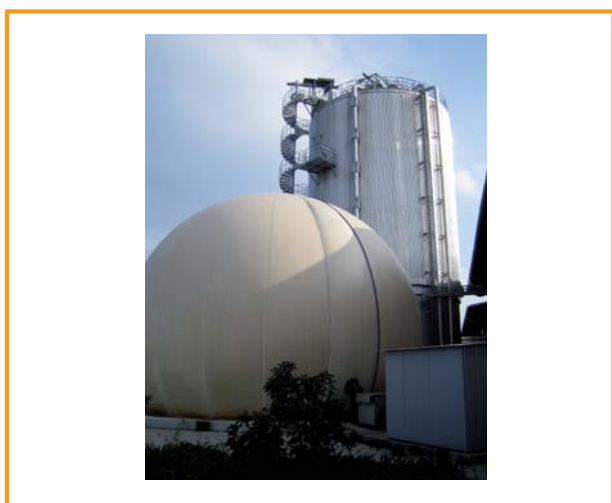
Figura 3.40: Gasômetro de camada dupla [Schüsseler, FNR]
