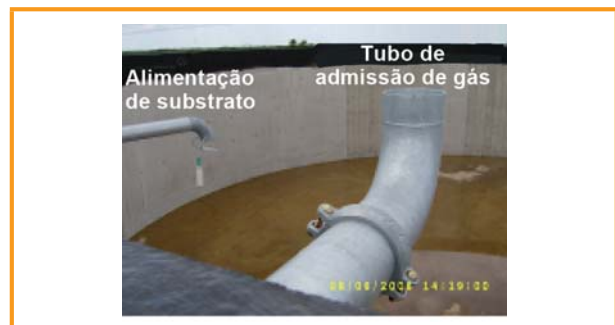
Figura 3.36: Dispositivos para transportar o gás sem distúrbios; tubo de admissão de gás com abertura voltada para cima (alimentação de substrato à esquerda) [DBFZ]
