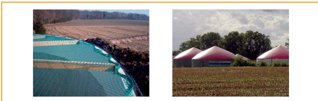
Figura 3.39: Base de suporte de cobertura inflável (esquerda); usina de biogás com coberturas infláveis [MT-Energie GmbH]
