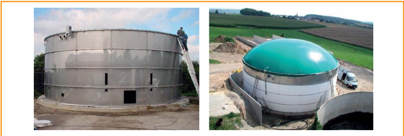
Figura 3.30: Biodigestor de aço inoxidável em fase de construção [Anlagen- und Apparatebau Lütke GmbH]
